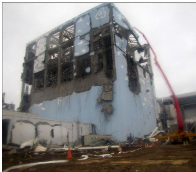
Pour éviter tout échauffement excessif et explosion, les secours s'efforcent de remplir avec une « girafe » la piscine du réacteur n°4 de Fukushima, l'un de leurs principaux soucis. Photo AFP
